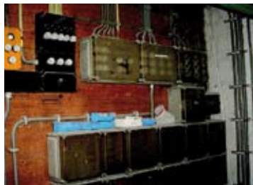
Samenstelling van diverse verdeelinrichtingen. Hier zou je een betere oplossing mogen verwachten.
