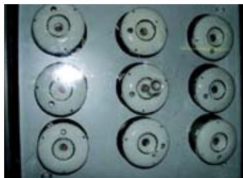
De onderste beveiliging in de middelste groep wijkt af van de rest.
